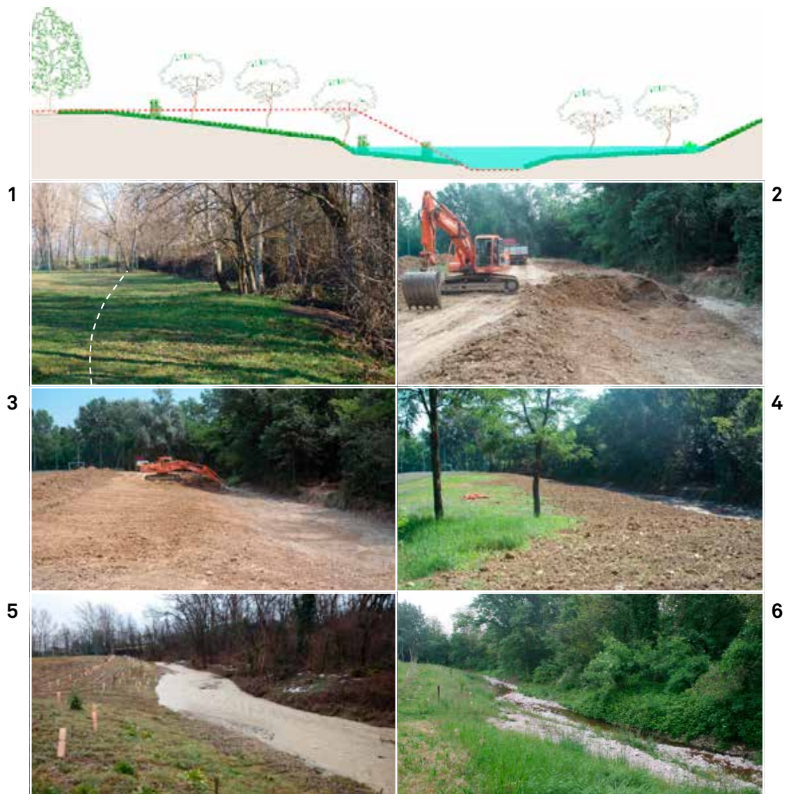
Figura 4 – Sequenza delle fasi di realizzazione dello sbancamento e allargamento di sezione per la creazione di nuova piana inondabile realizzato sul Rio Lavezza nella zona sportiva di Albinea (RE). Nell'immagine in alto lo schema progettuale dell'intervento realizzato.
