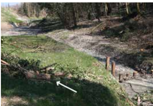
Figura 24 – Nell'ordine: esempio di rio in un tratto collinare durante una morbida; accumulo di vegetazione depezzata pronta per essere rimossa onde evitare il suo accumulo nella briglia filtrante visibile sullo sfondo; accumulo di ramaglia in una briglia a pettine che necessita di essere rimosso.
