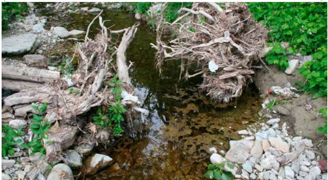
Figura 18 – Schema tipologico e foto di un intervento di diversificazione dell'habitat in alveo tramite l'utilizzo di radici esposte realizzato sul Rio Lavezza.
