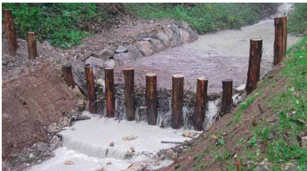
Figura 16 – Schema tipologico e foto di una briglia selettiva realizzata sul Rio Bianello nell’ambito del progetto Life RII. Si noti l’accumulo della ramaglia a monte dell’opera, che dovrà essere svuotata periodicamente per evitare il completo intasamento.
