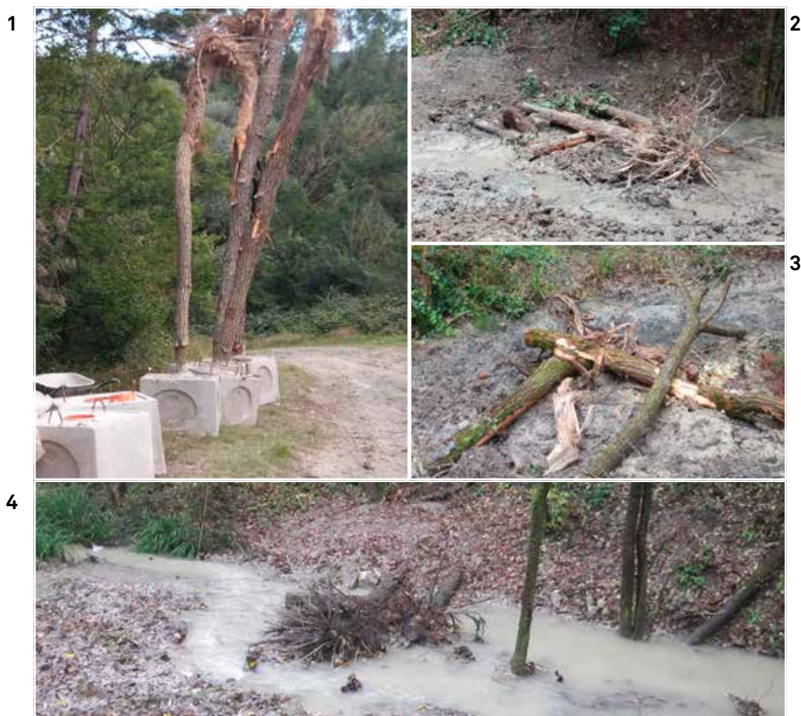
Figura 22 – Sequenza delle fasi di realizzazione di deflettori per l'aumento delle dinamiche laterali (Rio Bertolini).
