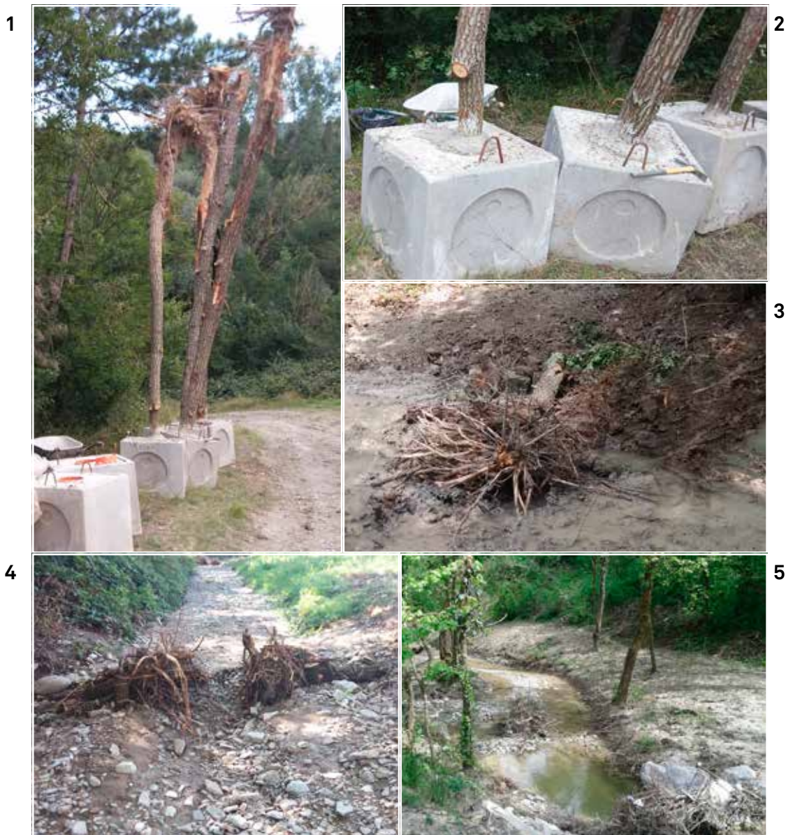
Figura 19 – Sequenza delle fasi di realizzazione di un intervento di diversificazione dell'habitat in alveo tramite l'utilizzo di radici esposte sul Rio Lavezza.
